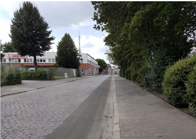
Neuer Asphaltstreifen für Fahrradfahrer in der Straße Plantage Findorff
